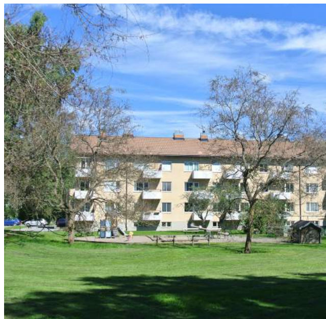
Pilrostangrepp i närparken Takteglet i Örby slott.
