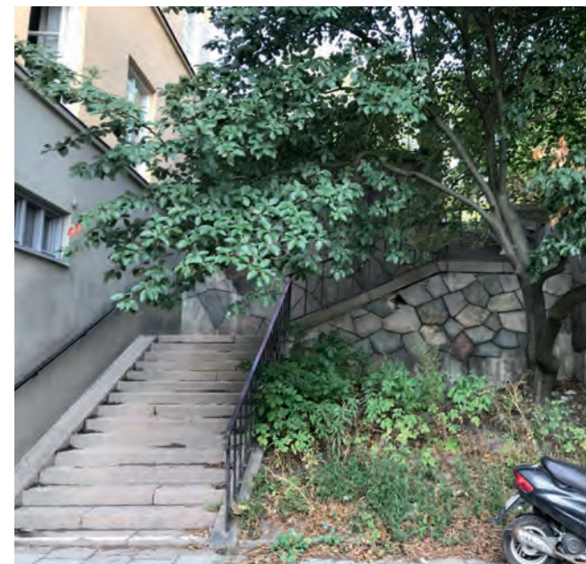
Trappan nerifrån Bondegatan med sina fina murar, granitsteg och smidesräcken.
